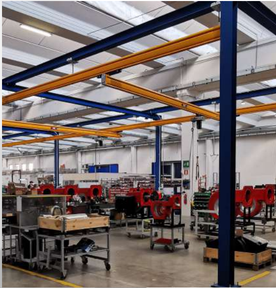
Производство горелок CIB UNIGAS в Италии.
